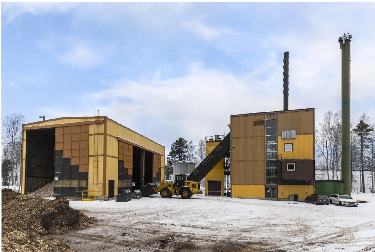
Mäntyharjun lämpölaite uudistettiin vuoden 2018 lopussa. Se tuottaa lämpöä lähes 140 asiakkaalle.
