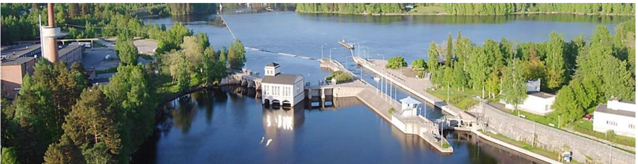
Kuva 5. Vaajakosken läntisen haaran Haapakosken vanha voimalaitos ja Pääjanne-Keitele-kanava-reitin Vaajakosken kanava alavirrasta ylävirtaan kuvattuna.
