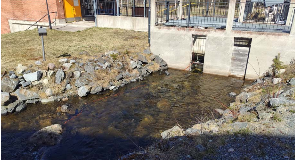
Kuva 3. Kalatien yläallas. Kamera ja muu laitteisto asennettiin vasemmanpuoleiseen aukkoon.
